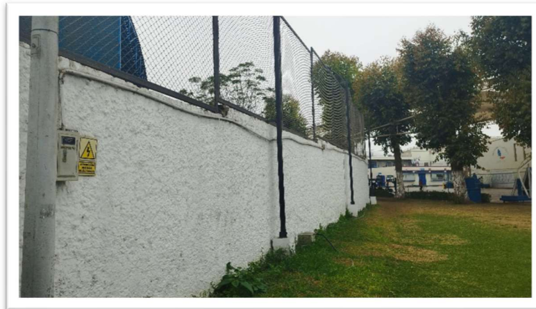
Terreno Existente en Tramo 3
