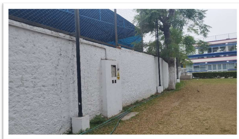
Terreno Existente en Tramo 3
