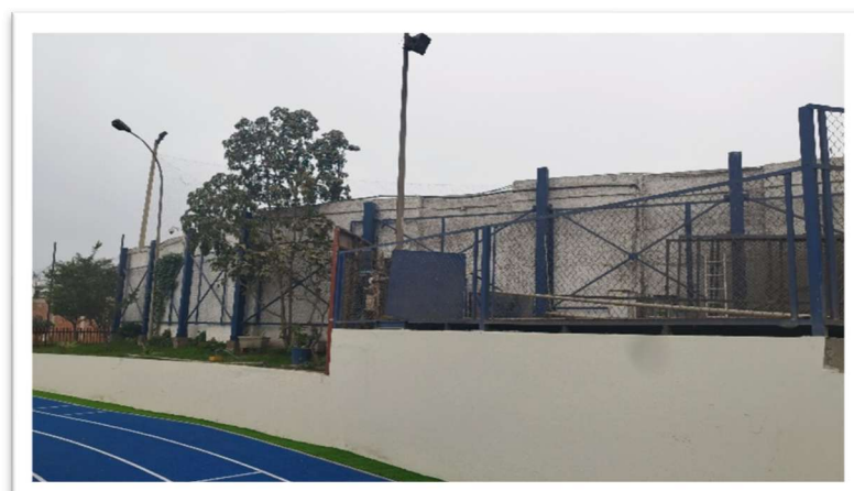
Terreno Existente en Tramo 5
