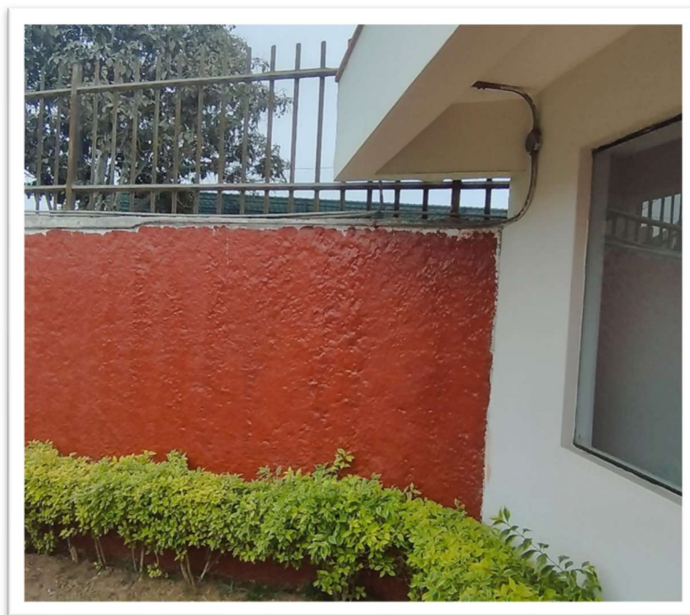
Terreno Existente en Tramo 2
