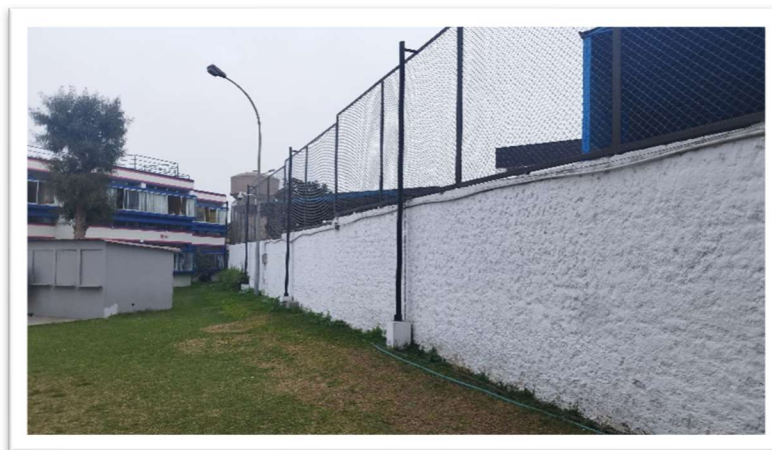
Terreno Existente en Tramo 3
